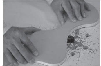
3. Corte con router
